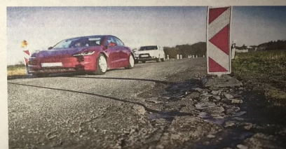
Die Linie 742 verkehrt normalerweise über die Millrather Straße, die Ö1 auf der Gruitener Straße. Während der Bauzeit werden sie umgeleitet. FOTO: KOHLER
